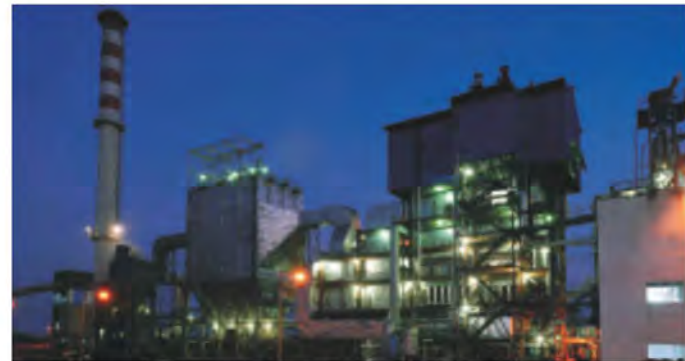
90 TPH, 50 kg/cm 2 . g, 485 deg. C Chaudière AFBC alimentée au charbon de Gujarat Flourochemicals Ltd. en Inde.
