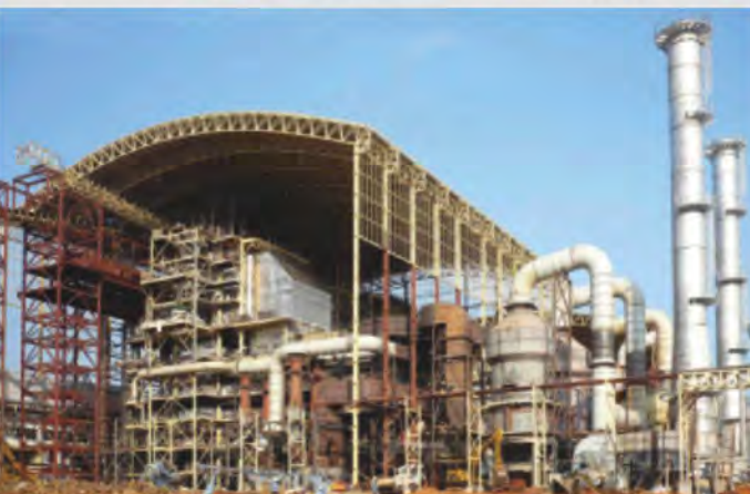
Chaudière alimentée à la biomasse pour une centrale de 8 MW en Espagne. Nous fournissons la biomasse / des chaudières multicomcombustible jusqu'à 250 TPH.
