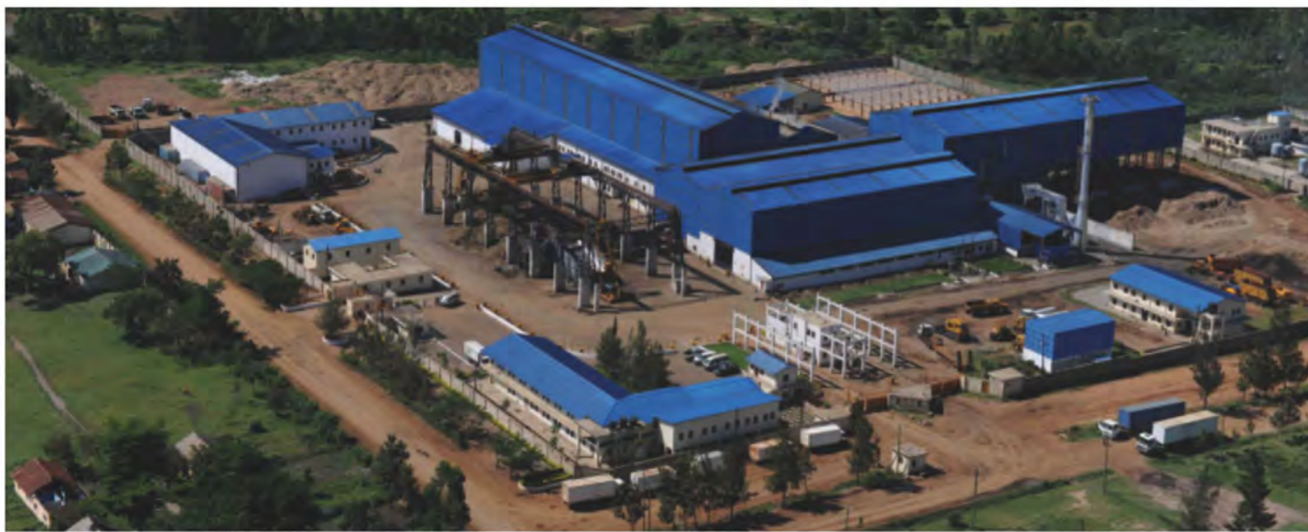
Usine sucrière mise en place clé en main pour Kibos Sugar & Allied Industries Ltd., Kenya ayant une capacité de trituration de 400 000 tonnes de canne par an. En cours d'expansion à une capacité de trituration de 650 000 tonnes de canne par an avec la centrale de cogénération de 110 000 MW par an.
