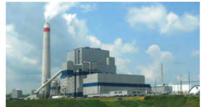
La plus grande chaudière supercritique à combustion au monde (770 Mwe) inspirée de la conception des tubes évaporateurs du type Benson commandée par Foster Wheeler à Longview Power LCC, États-Unis.
