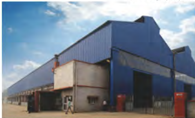
Usine de coulage d'Isgec (U.P. Steels) à Muzaffarnagar (U. P.), Inde.
