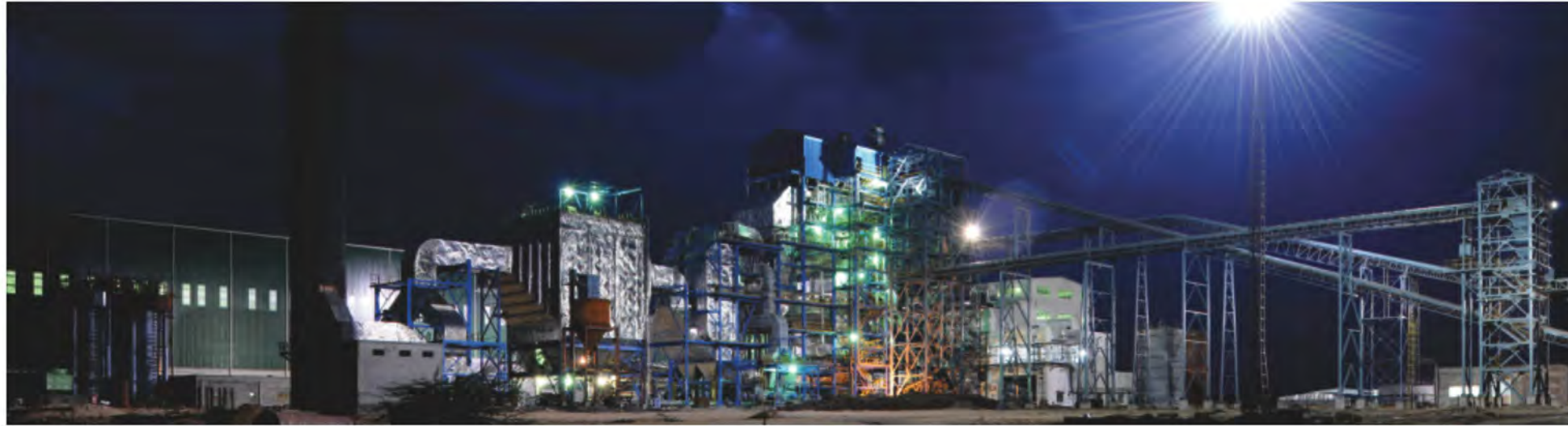
Centrale de cogénération fonctionnelle de 25 MW fournie sur la base EPC à Core Green Sugar & Fuels Pvt. Ltd., Inde
