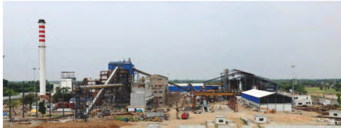
Usine de co-génération fonctionnelle de 20 MW fournie sur la base EPC , y compris système de prise d'eau, à HPCL Biofuels Ltd., Lauriya, Inde
