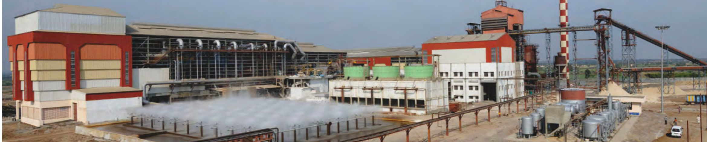
Moulin de 45" X 90" pour Xinavane, Mozambique, en cours d'assemblage dans nos chantiers. Nous avons fourni 350 installations de broyage de canne de tailles diverses à des clients à travers le monde entier.
