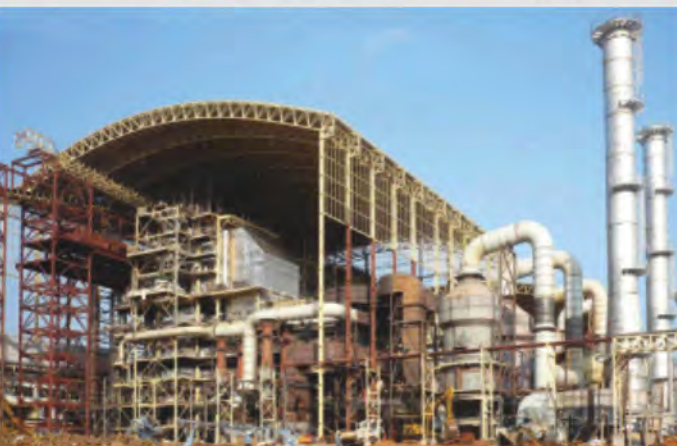
Chaudière alimentée à la biomasse pour une centrale de 8 MW en Espagne. Nous fournissons la biomasse / des chaudières multicom bustible jusqu'à 250 TPH.
