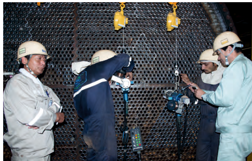
Автоматическая приварка труб к трубной решетке в этиленоксидном реакторе
